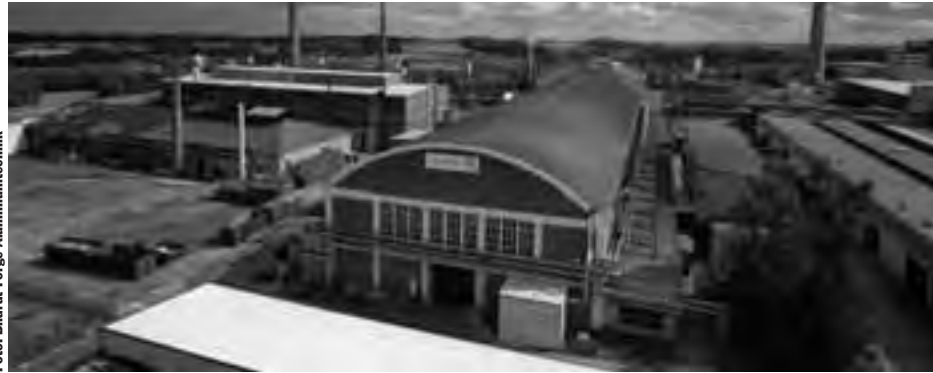
Produktionshalle der Bharat Forge Aluminiumtechnik in Dresden
