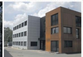
Pohl Europlate®-Fassade in Cortenstahl und Aluminium
