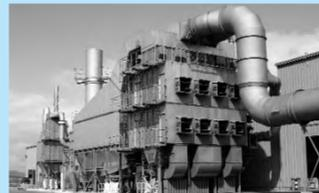
Filter trockenes Kalkhydrat abgeschieden wird. ► Das verdampfende Wasser kühlt das Abgas und bewirkt eine enorme Verbesserung des Abscheidungsgrades für SO<sub>x</sub> (>95%).
